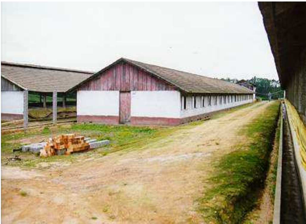
Apêndice J -- Modelo de instalação física de granja de suíno. Na lateral direita, observamos calha para recebimento dos efluentes onde é levado por gravidade até as esterqueiras.
