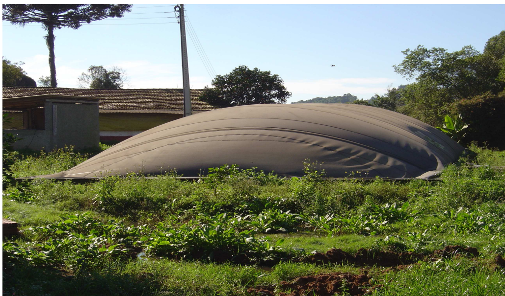
Apêndice O - O biogás, é uma das alternativas para aproveitamento do dejetos e produção de gás metano ( \text{CH}_4 ) utilizado para aquecimento da granja e uso na residência. Neste processo, ainda há sobra de lodo, que pode ser espalhado nas lavouras. Na área de estudo verificou-se apenas um biogás instalado.
