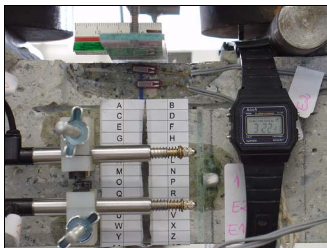
Figura 115 : Imagem utilizada para medição da abertura de fissura, na qual a viga está inclinada em relação ao eixo da fotografia
