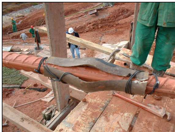
Figura 18 – Detalhe do espaçador colocado no chumbador.
