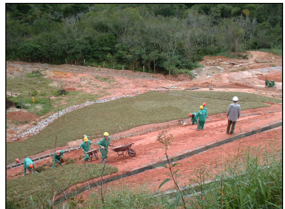
Figura 14 – Colocação de grama em leiva canaletas de drenagem (proteção superficial).
