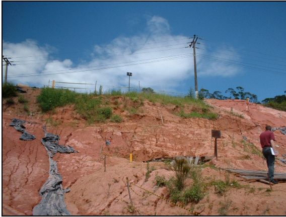
Figura 11 – Vista Geral do talude, antes da estabilização.
