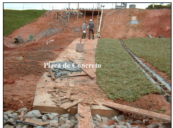
Figura 16 – Proteção mecânica do gasoduto – Laje em concreto.
