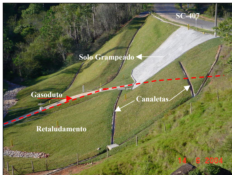
Figura 6 – Vista geral do talude após a estabilização. Fonte: Arquivos internos TBG.
