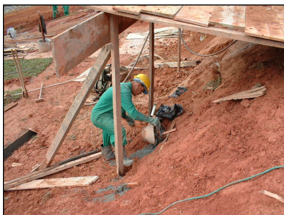
Figura 20 – Preenchimento do furo com calda de cimento.
