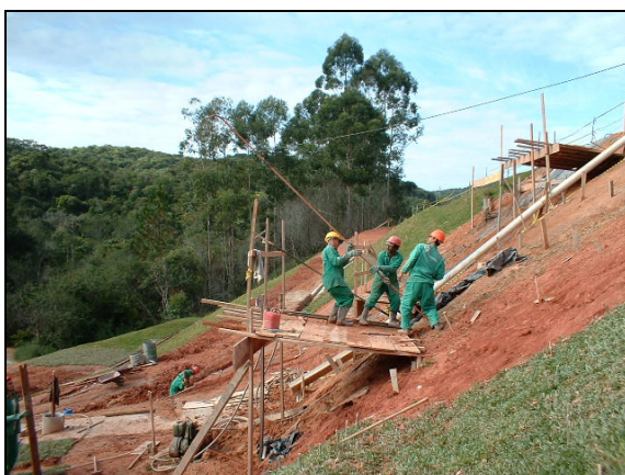
Figura 19 – Inserção do chumbador no furo.
