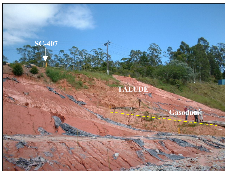
Figura 4 – Vista geral do talude antes da estabilização.
