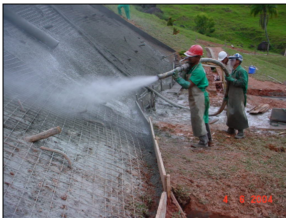
Figura 23 – Execução do concreto projetado.
