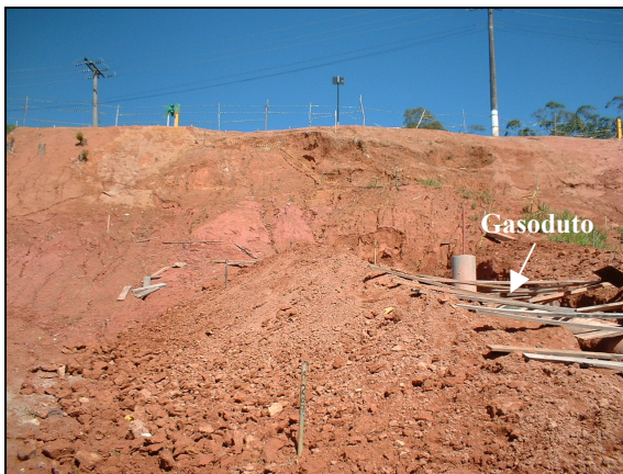
Figura 13 – Proteção provisória do gasoduto e nivelamento da superfície.
