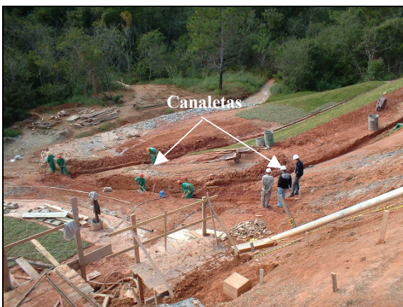
Figura 15 – Confeção da drenagem superficial – Canaletas centrais e de pé de talude.
