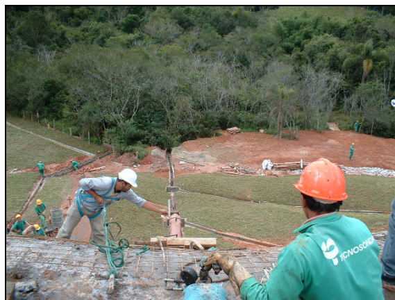
Figura 26 – Detalhe da execução do ensaio.
