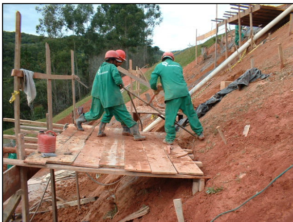
Figura 17 – Execução dos furos para colocação dos chumbadores.
