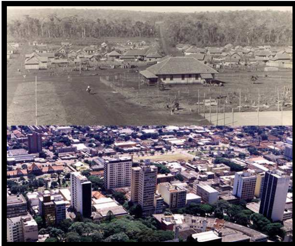
Vistas parciais da cidade de Londrina no início da colonização e na década de 1990
