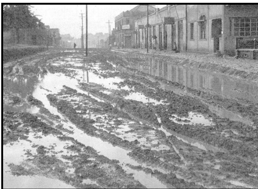
FOTO 4 – Avenida Paraná (atual Calçadão) na década de 1940, após período de chuvas.
