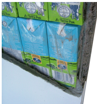
Figura 24: Apresentação final, com detalhe para espessura da argamassa.
