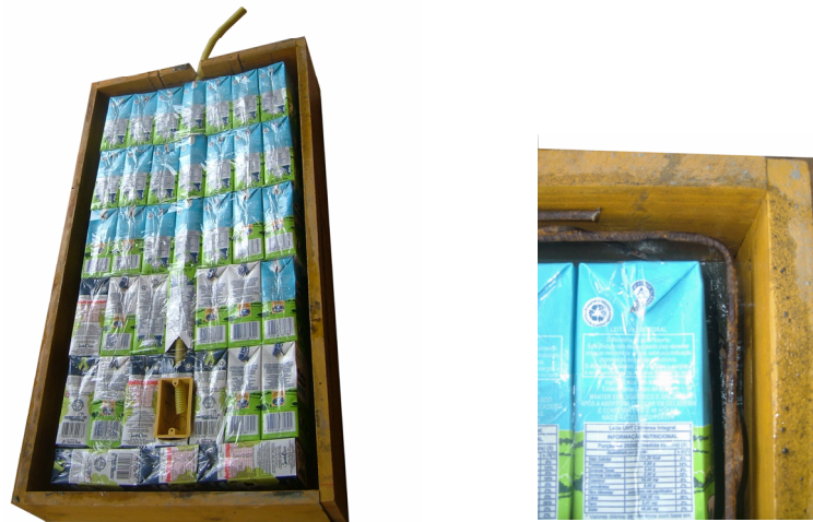
Figura 21: Colocação do painel na fôrma sobre argamassa. Colocação da treliça perimetral.
