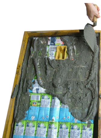
Figura 22: Aplicação da segunda camada de argamassa.
