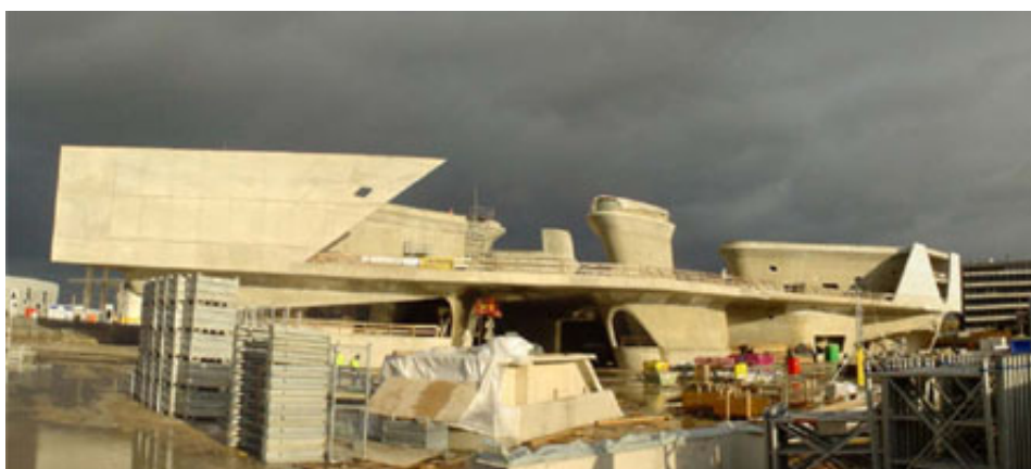
Fig. 12: Centro de Ciência em Wolfsburg em construção.
