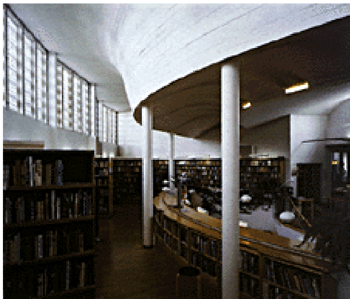
Figura 52: Detalhe da curvatura do teto que direciona a luz para a área das prateleiras de livros (Fonte: http://www.jkl.fi/aalto/library/pics1.html )
