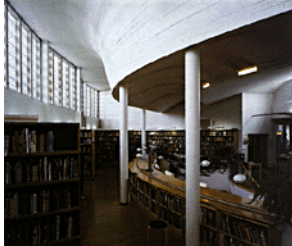
Figura 128: Detalhe da curvatura do teto que direciona a luz para a área das prateleiras de livros (Fonte: http://www.jkl.fi/aalto/library/pics2.html )
