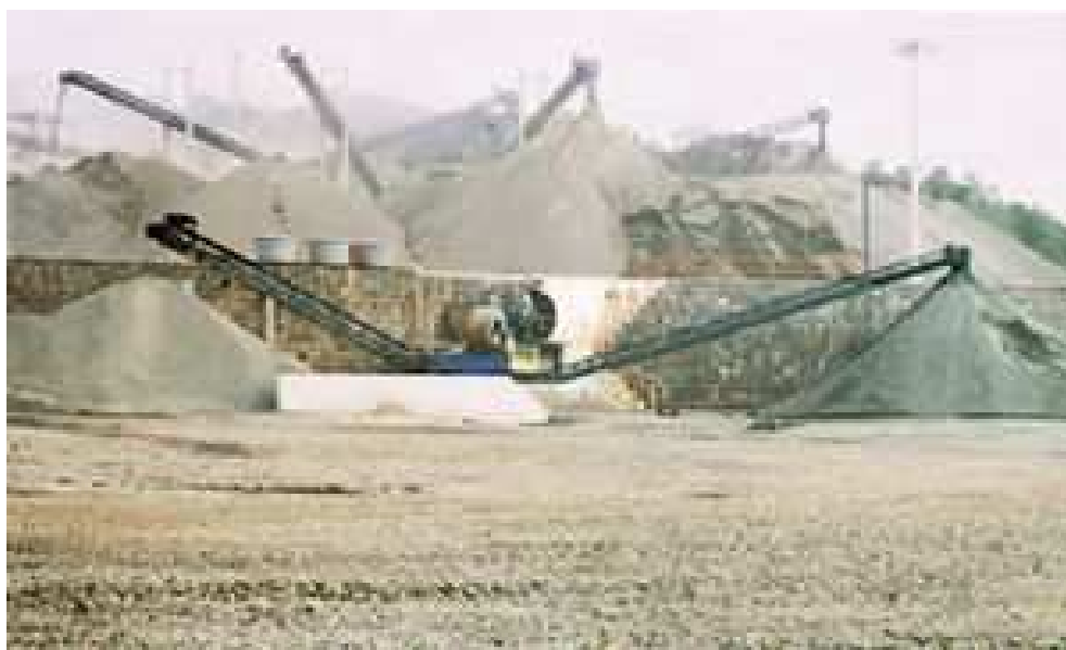
FIGURA 13 - Vista geral do equipamento de lavação da areia
