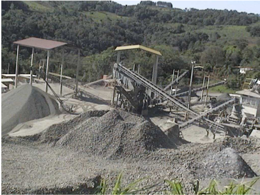
FIGURA 8 - Aspecto geral do britador
