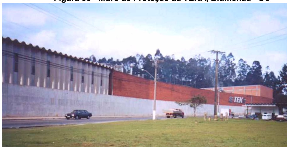
Figura 56 - Muro de Proteção da TEKA, Blumenau - SC
