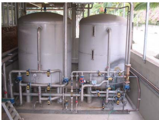
Figura 22: Filtros de recuperação de água com quartzo (à esquerda) e com resina (à direita).
