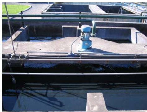
Figura 38: Um dos tanques de neutralização onde ocorre a redução do pH do efluente com o uso do CO_2 .
