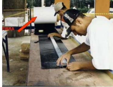
Figura 2.16 – Corte das fibras de carbono (MACHADO, 2002)
