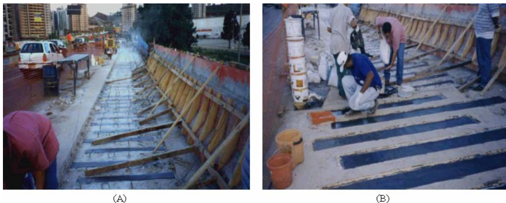
Figura 2.6 – Reforço do Viaduto Sobre a BR-040 na via de acesso ao BH Shopping (MACHADO, 2002)
