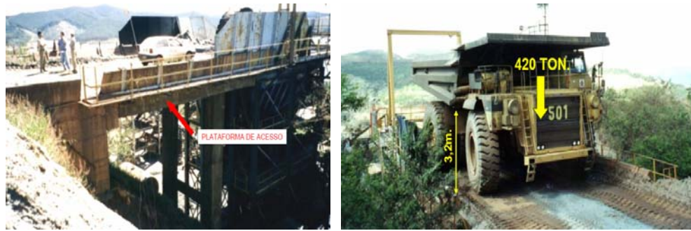
Figura 2.5 – Recuperação da Ponte de acesso ao Peneiramento P22 da Mina de Conceição (MACHADO, 2002)
