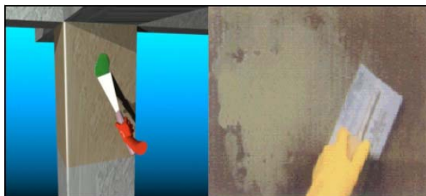
Figura 2.15 – Aplicação do regularizador de superfície (MACHADO, 2006)
