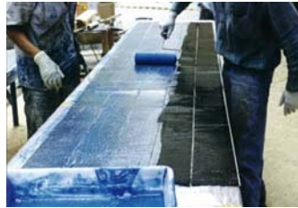
Figura 2.17 – Aplicação da resina de saturação na fibra de carbono (MACHADO, 2002)
