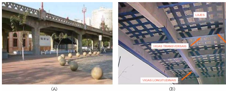
Figura 2.3 – Viaduto Santa Tereza (MACHADO, 2002)
