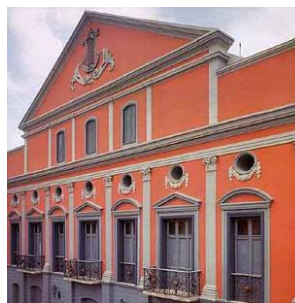
FIGURA 83 – Teatro Arthur Azevedo, inaugurado em 1817 – Fachada neoclássica composta de três pavimentos e determinada por frontão triangular. Pilastras coríntias dispõem-se ao longo do segundo pavimento.
