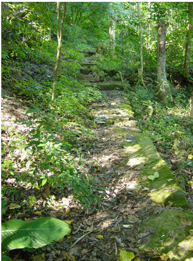
Figura 13: Detalhe das ruínas do antigo estábulo.
