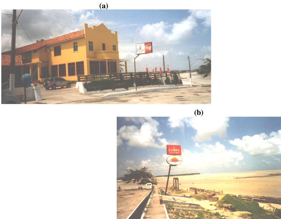
Foto 02 – (a) Vista do primeiro hotel da cidade que se chamava Atlântico, atualmente conhecido como hotel Salinópolis. (b) Resultados da ação do mar em uma praça localizada na orla que inicialmente serviu de atrativo para a construção deste hotel (Foto Francinete Brito – abril/2002)
