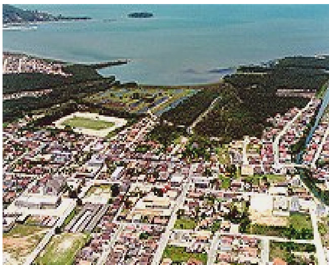
Figura 5: Vista aérea do município de Palhoça, focalizando a proximidade das construções urbanas do Manguezal da Palhoça.
