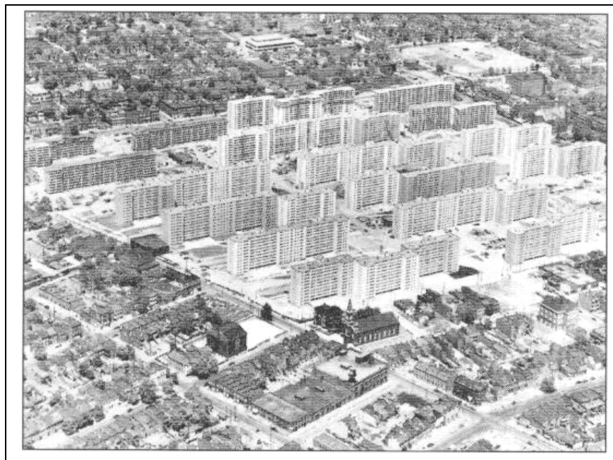
Figura 02: Projeto habitacional Pruitt-Igoe, St. Louis. Por Minoru Yamasaki, concluído em 1955. “Os defensores do estilo Internacional prometiam que a estética de fábrica podia melhorar a vida dos moradores, uma espécie de garantia de que ‘se nós construímos eles florescerão’. Projetado como um modelo de habitação eficiente, este projeto de baixo custo tornou-se uma armadilha mortal. Blocos de torres individuais, com repetição em grande escala de elementos uniformes, não apenas deixaram de melhorar a condição humana, mas também mostraram-se uma influência prejudicial. A habitação de massa uniforme – presa fácil para o vandalismo e crime – só foi considerada socialmente não desejável tardiamente. Estas torres, julgadas prejudiciais ao espírito e à natureza dos moradores, foram dinamitadas 17 anos após a construção”.
