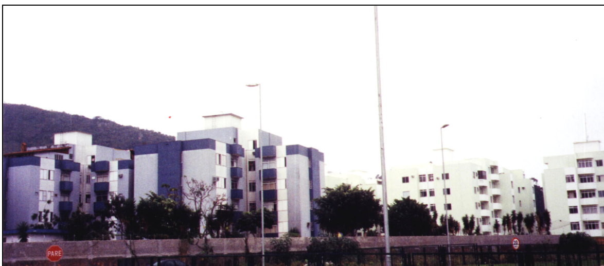
Figura 05: Passado. Conjuntos Residenciais Multifamiliares construídos na década de 80, localizados no bairro Trindade da cidade de Florianópolis, que apresentam as mesmas características espaciais e de implantação dos conjuntos executados hoje em dia. Fonte: Fotografia realizada pela autora em 2003.
