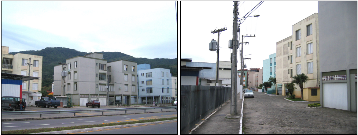
Figuras 38 e 39: Conjunto Residencial Verde Vale, no bairro Itacorubi, Florianópolis. Fonte: Fotografia da autora, 2004.
