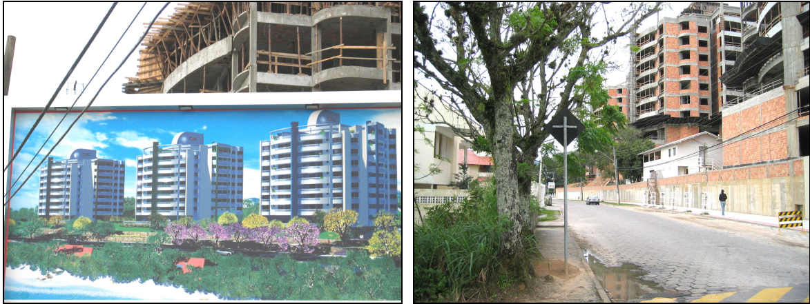
Figuras 59 e 60. Painel de divulgação do empreendimento e a vista real da obra. A divulgação não reflete a realidade. Ainda na figura 72 percebem-se os “vazios construídos”, onde um alto muro cego de fechamento não permite a comunicação física e/ou visual do empreendimento com a rua, e o bairro. Negando qualquer possibilidade de integração de seus futuros moradores com o bairro. Fonte: Fotografia da autora.
