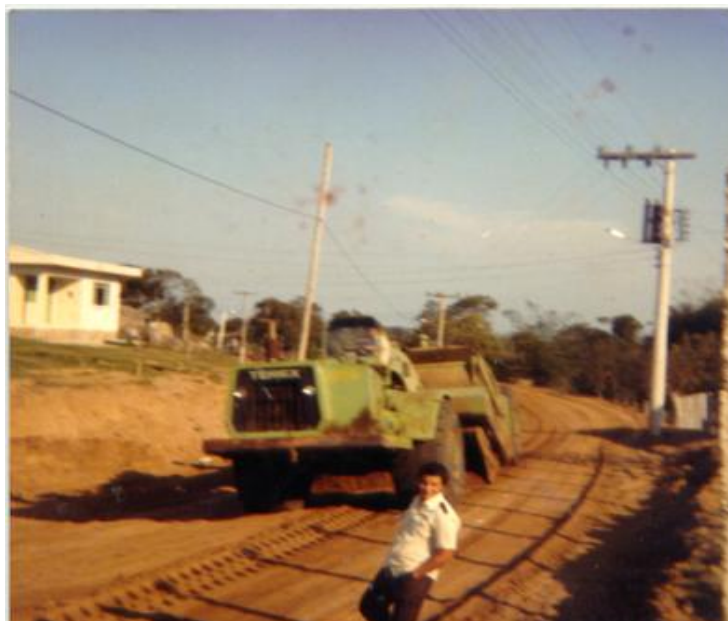
FIGURA 52: A obra de asfaltamento da estrada geral (trecho sul - 1ª etapa)
