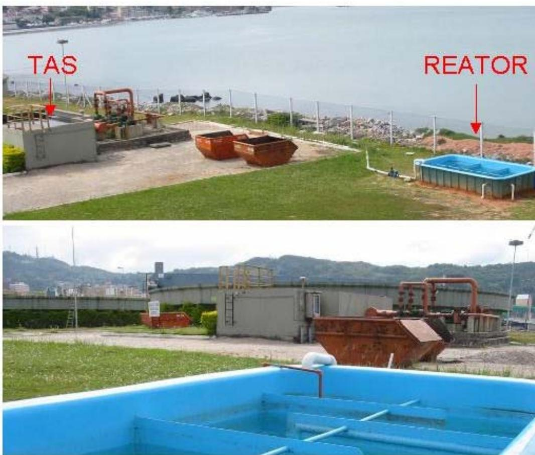
**FIGURA 21** – Instalação do sistema de desinfecção.
