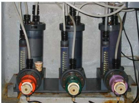
**FIGURA 23** – Bombas dosadoras de HCl (alaranjada), H<sub>2</sub>O (verde) e NaClO<sub>2</sub> (violeta).
