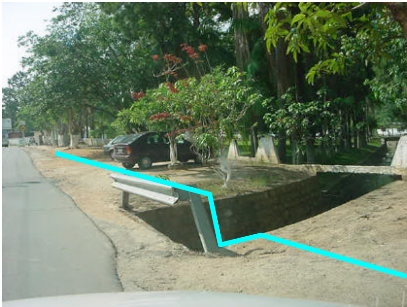
Foto 4 – Travessia córrego – método: cavalote concretado Rua Engelberto Koerich - São Pedro de Alcântara -SC
