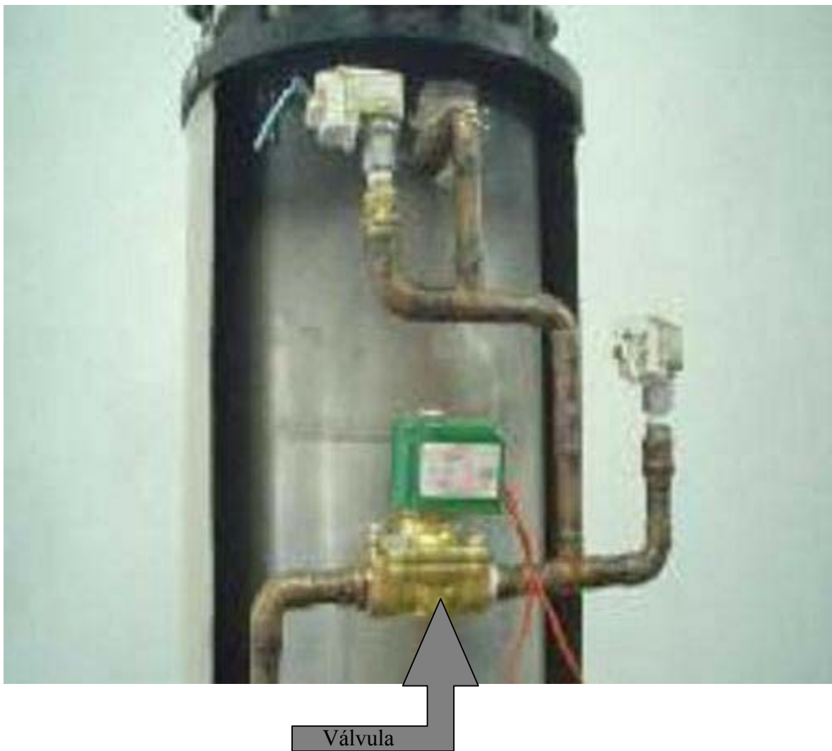
Figura 5.13 - Válvula de expurgo do sistema proposto.
