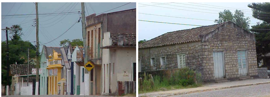
Figura 20: Fachadas de casas açorianas (esquerda) e construção rústica tilizando blocos de granito (direita), na principal rua de Capão do Leão.
