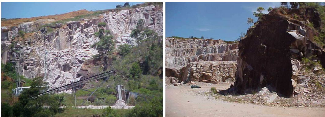
Figura 31: Vista parcial da área de lavra da mineradora Ivaí.
