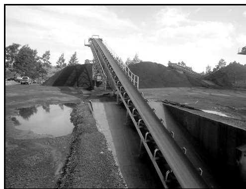
Figura 17 – Estação de tratamento piloto da Carbonífera Metropolitana S.A.
