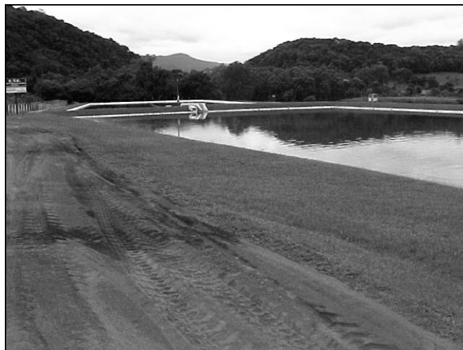
Figura 18 – Sistema de Lagoas Aeróbicas
