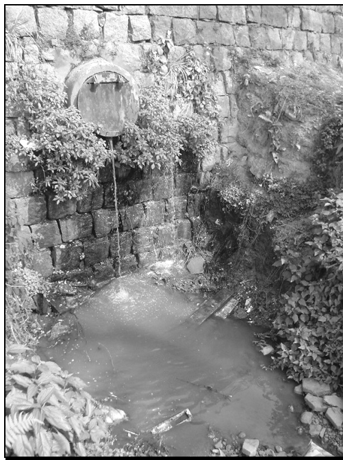
Figura 12 - Despejo de esgoto sanitário no Rio Tubarão.
