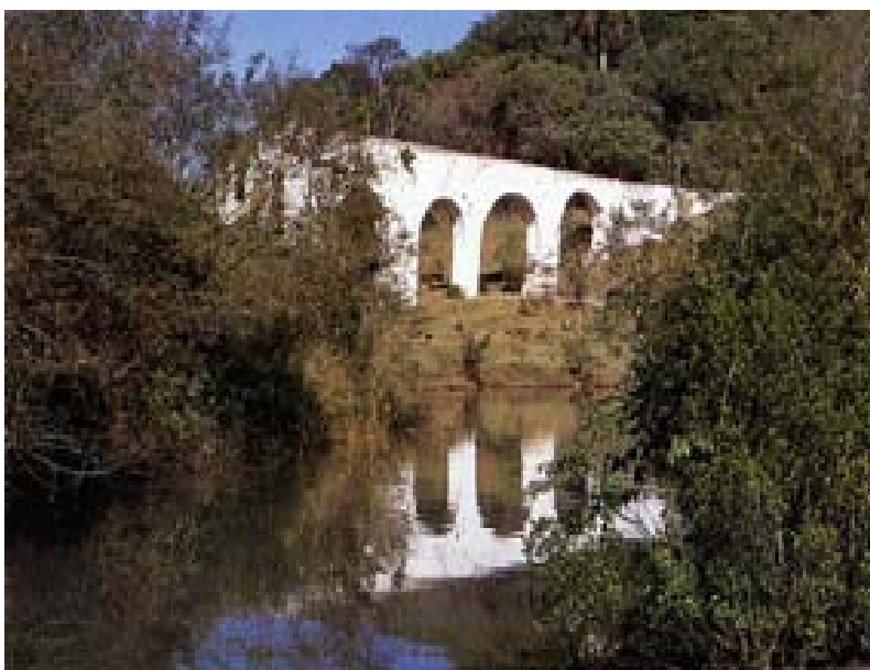
FIGURA 18. Aqueduto de São Miguel– Biguaçu.
