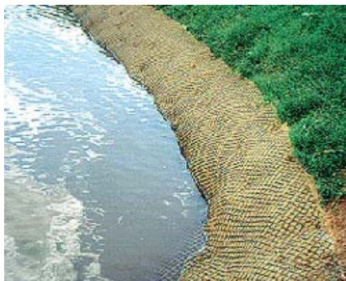
FIGURA 51. Obra de contenção com biomanta antierosiva.
