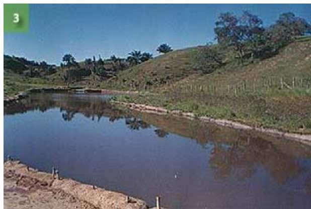
FIGURA 54. 3. Curso d'água já totalmente recuperado e protegido, mostrando a eficiência e segurança do produto, evitando novos assoreamentos e solapamentos das margens.
