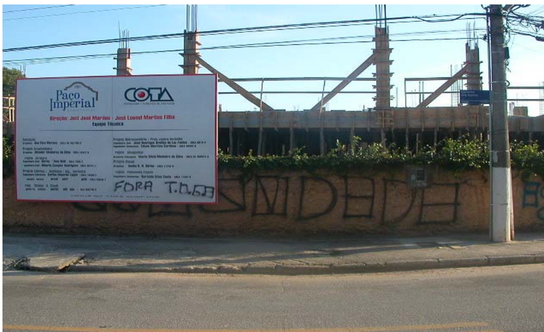
FIGURA 29 Obra embargada por Ação Civil Pública em Santo Antônio De Lisboa.
