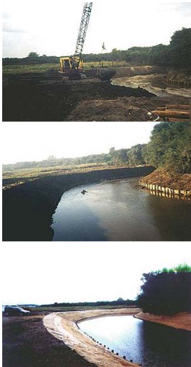
FIGURA 55. Desassoreamento de rio usando técnicas de Bioengenharia.
