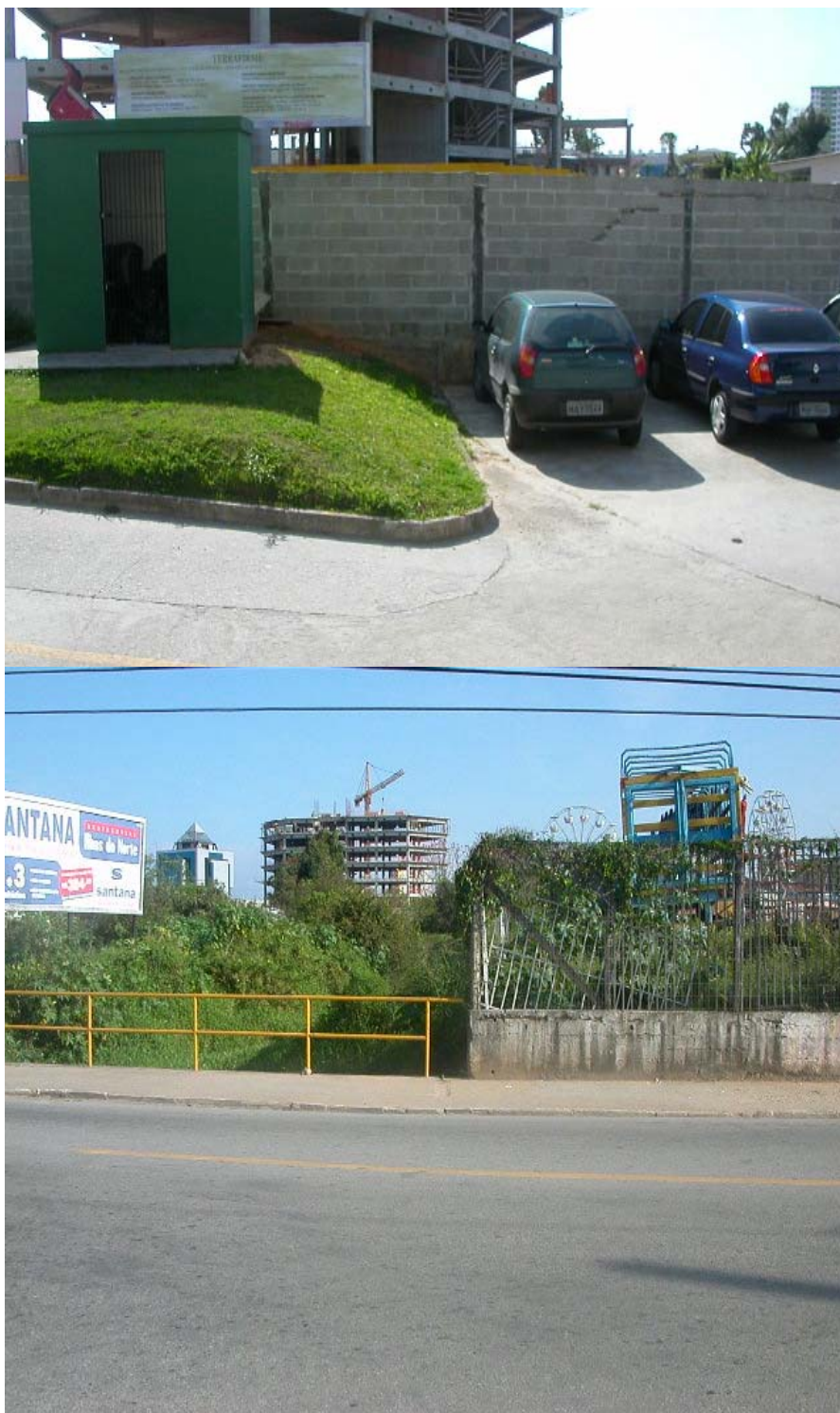
FIGURA 49. Centro Empresarial em construção, ao lado do Fórum de São José.
