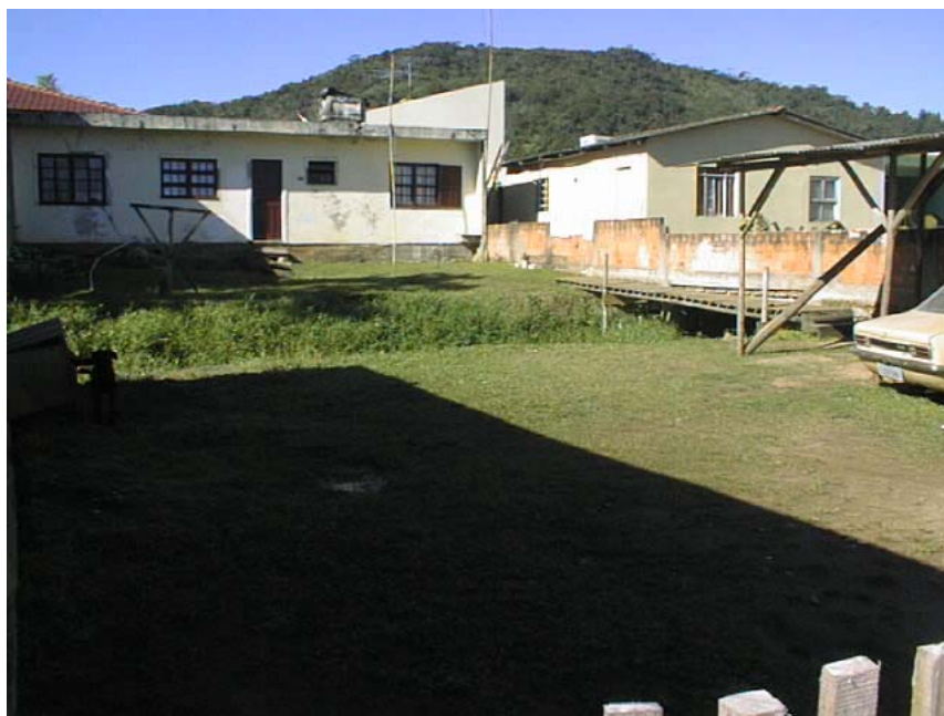
FIGURA 39. Canal que corta o Jardim Carandaí – Biguaçu.
