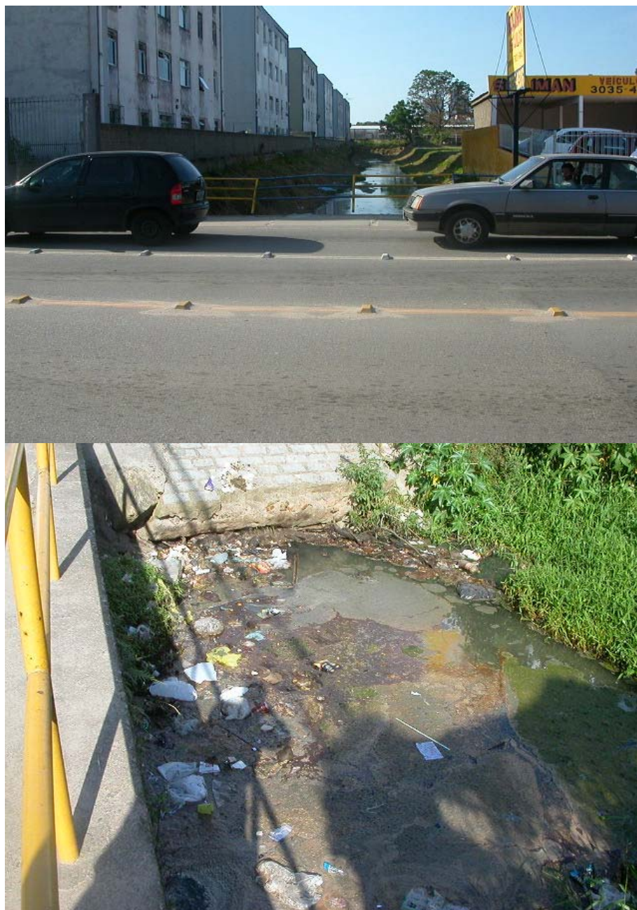
FIGURA 50. Trecho a montante do Fórum e Prefeitura de São José.
