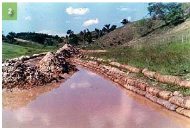
FIGURA 53. 2. Trabalho já em fase adiantada, final do processo de desassoreamento e proteção das margens com uso de retentores de sedimentos
