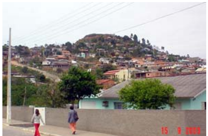
Figura 13 - Ilustração da ocupação de morros em Serraria.
