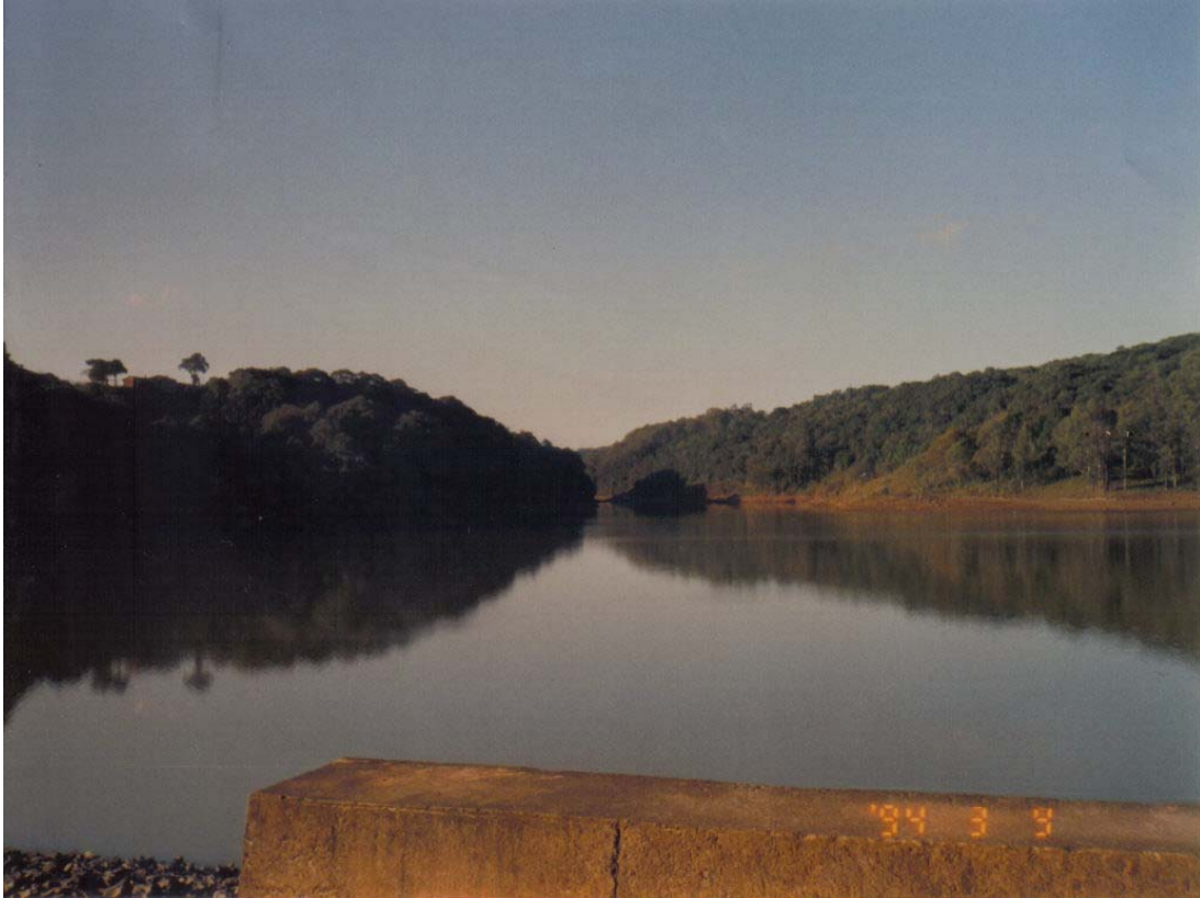
Foto 1 – Vista parcial da Barragem Maestra.
