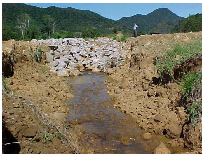
Figura 16 – Barramento de pedras soltas preparado para a derivação de água na Sociedade de Vale de Gasparinho Quadro, em Gaspar (Foto: Guarim Liberato Junior, 2002).
