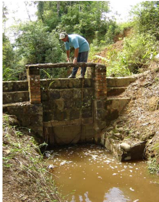
Figura 20 – Controle da água feito por meio de comporta na sociedade de Vala de Pinhalzindo/Volta Grande, que tem vala mestra com 13 quilômetros. (Foto: Guarim Liberato Junior).
