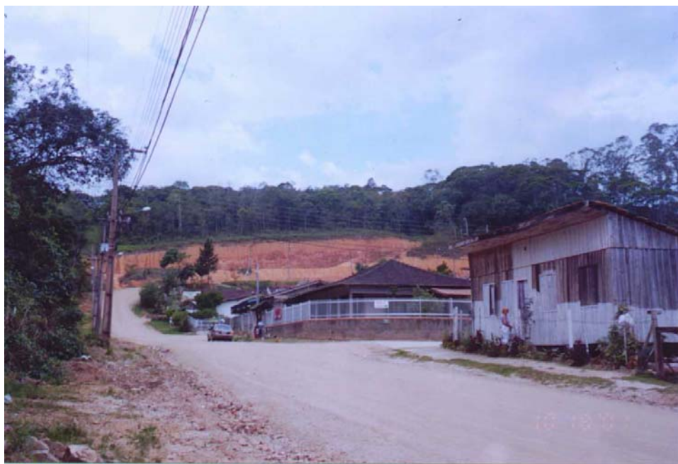
Foto 26 :Cicatriz bastante erodida, recorte da vegetação provoca deslizamento. Loteamento Pérola do Vale, bairro Itoupava Central.
