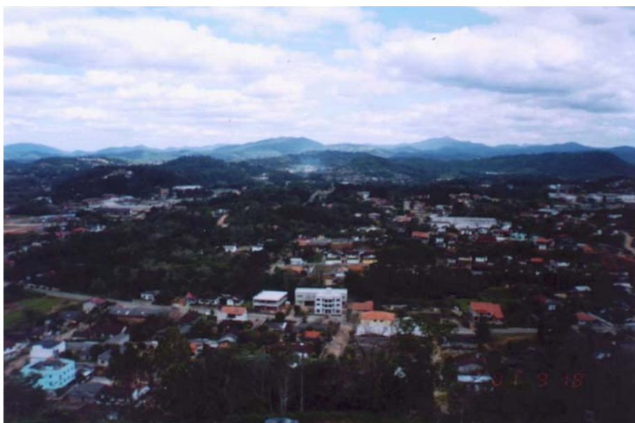
Foto 14 : Vista parcial do Bairro Salto do Norte.
