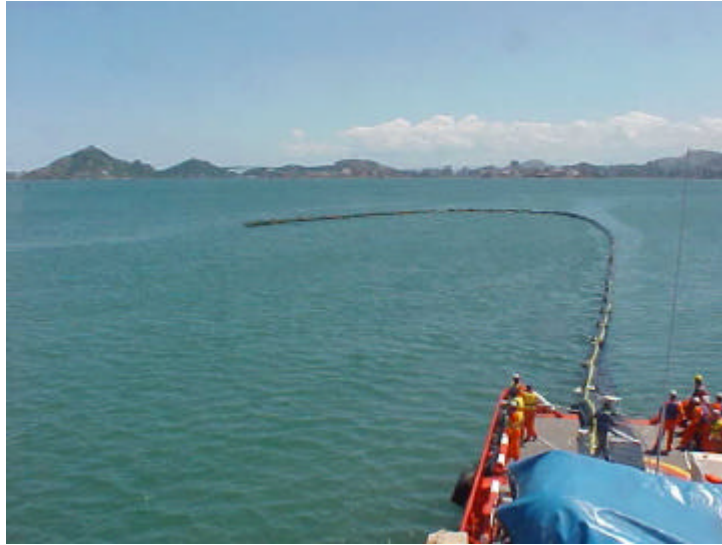
Figura 11 - Barreira de contenção oceânica Fonte: Banco de imagens da PETROBRAS.
