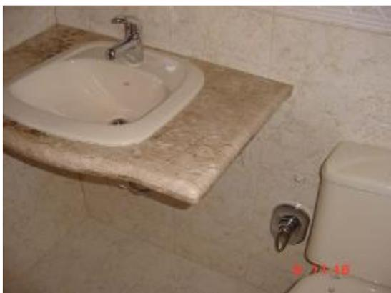
Nesta foto são identificados vários itens personalizados: (i) todos os materiais de revestimentos (cerâmica do piso e azulejo) foram alterados, (ii) o cliente optou por aquecimento a gás em sua unidade, (iii) as especificações (cuba e bacia sanitária) foram alteradas, (iv) colocou-se ducha higiênica com misturador monocomando, assim como a torneira, (v) a bancada teve seu material alterado e o desenho personalizado.
