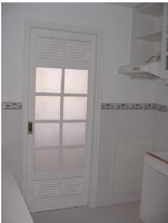
Aplicação de azulejos em meia parede da cozinha arrematada por uma faixa cerâmica. A parte superior da parede recebeu pintura epóxi.
