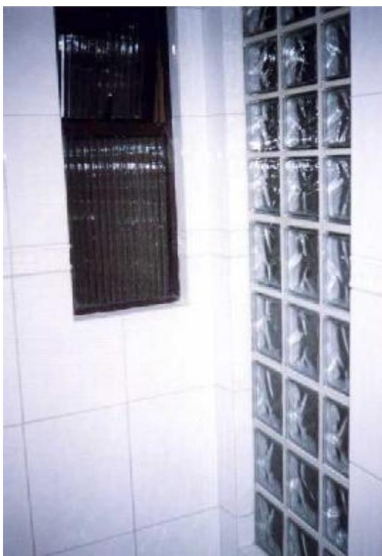
Estes tijolos de vidro foram colocados na parede que divide o box do banheiro e a suíte do casal.
