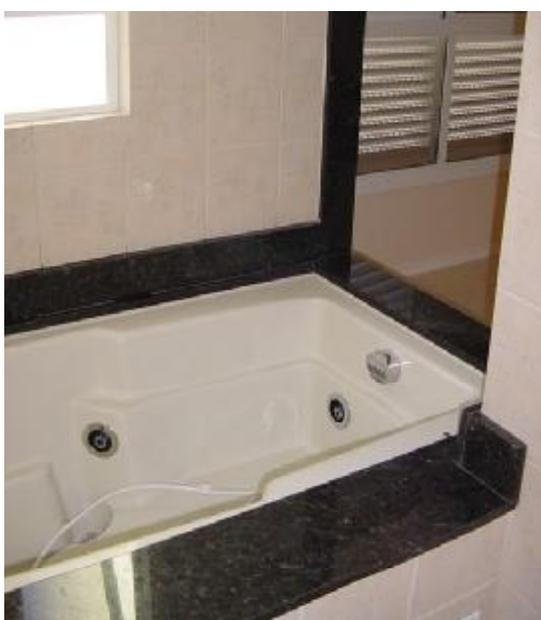
Instalação de banheira deixando um grande vão voltado para a suíte. Posteriormente o cliente irá colocar um vidro temperado, preservando a transparência desejada.
