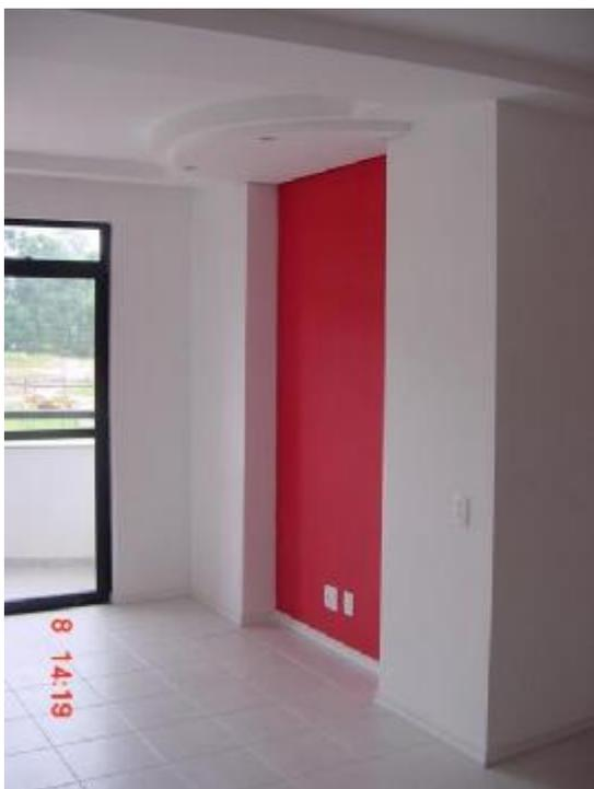
Tanto o nicho como o detalhe no gesso – executados em gesso acartonado – , a iluminação e a cor diferenciada na parede do fundo foram feitos para embutir um móvel que o cliente já possuía e não queria se desfazer.
