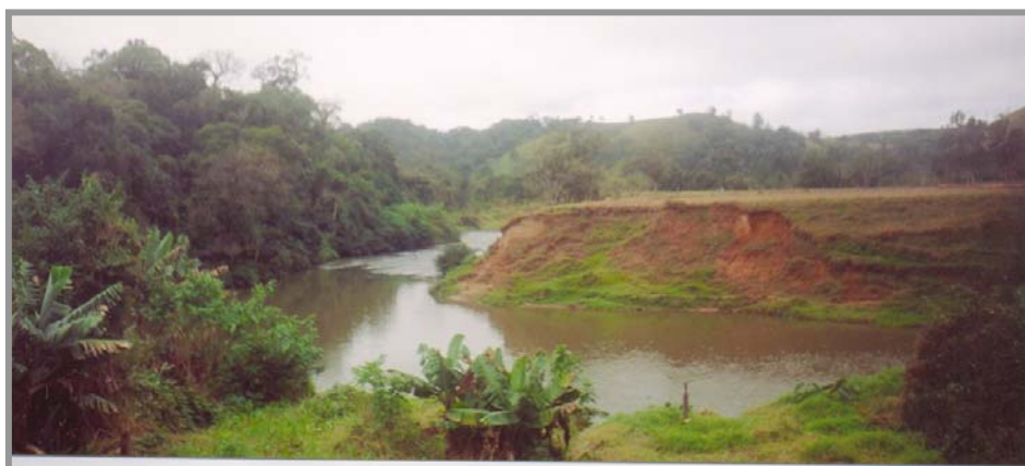
Figura 34: Retirada total da mata ciliar da margem direita do rio Taió causando erosão .
