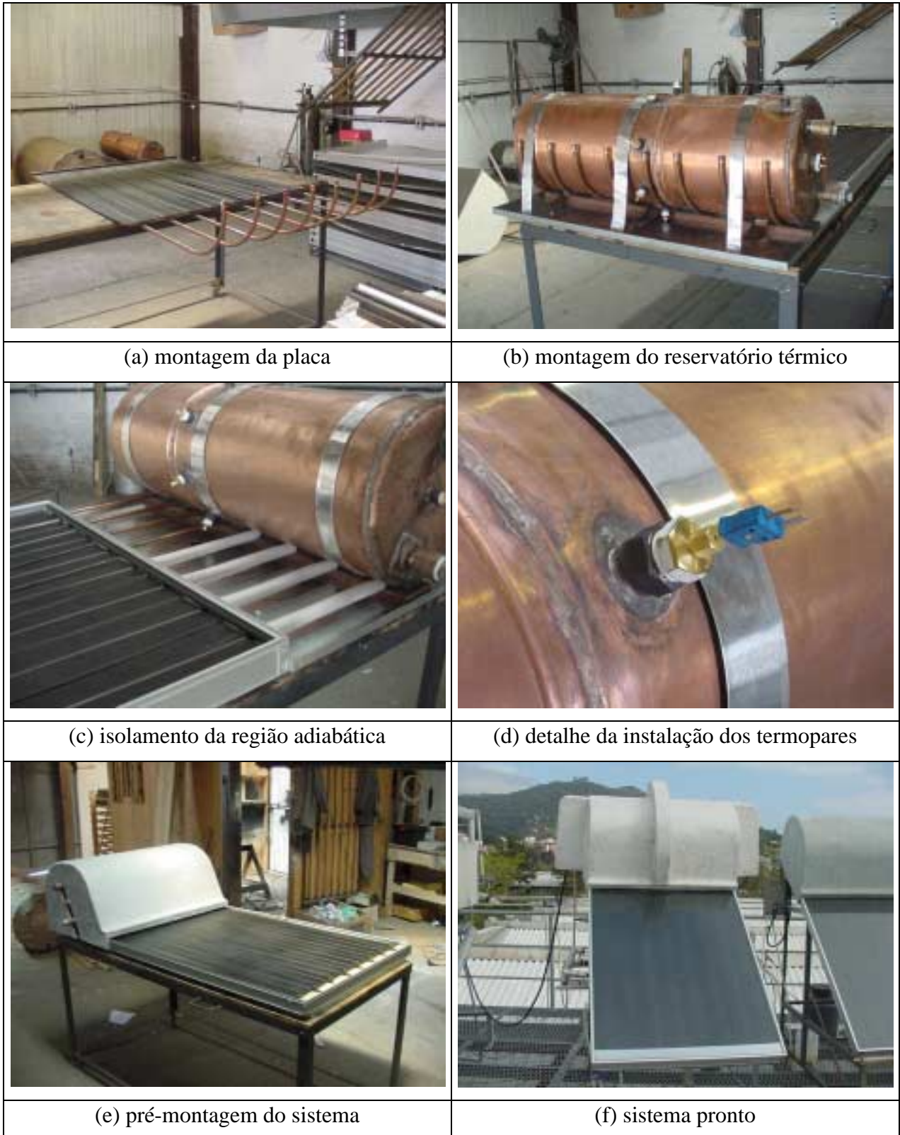
Figura 20. Etapas de fabricação do sistema de aquecimento solar.
