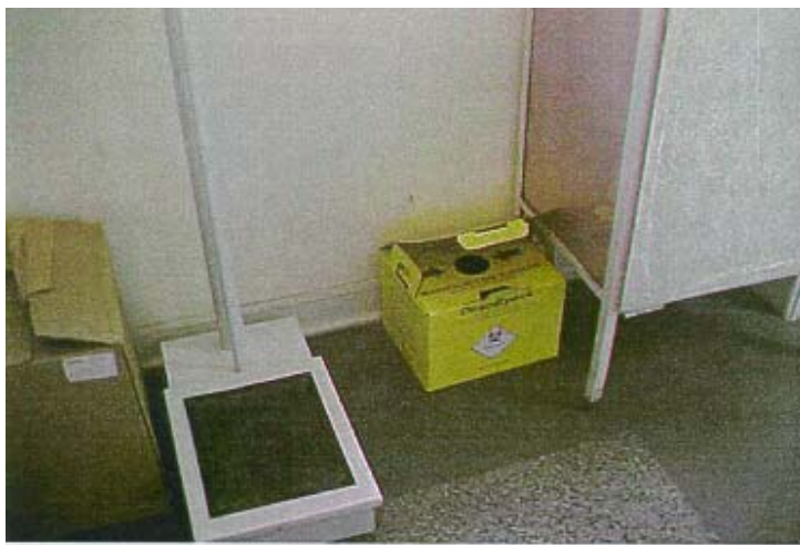
FIGURA 03 – ACONDICIONAMENTO, GUARDA E MANEJO INTERNO INADEQUADO.
