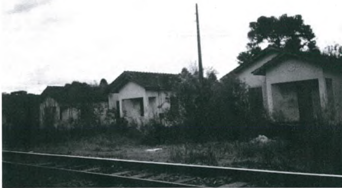
Figura 13 – Fotografia tirada por mim em 22 de julho de 2001. Observa-se que a fachada das casas são de um estilo bastante simples, da mesma forma como já se pôde observar nas fotografias da estação Afonso Camargo . Apesar de estarem inteiras, a pintura das casas estão desgastadas e o mato alto.
