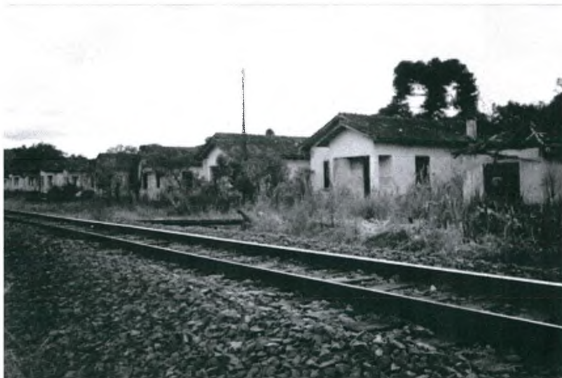
Figura 14 – Fotografia tirada por mim em 22 de julho de 2001. Verifica-se a proximidade que os trilhos ficavam das casas dos ferroviários e o estado de abandono que se encontra a área. A fotografia mostra os trilhos seguindo no sentido oeste.
