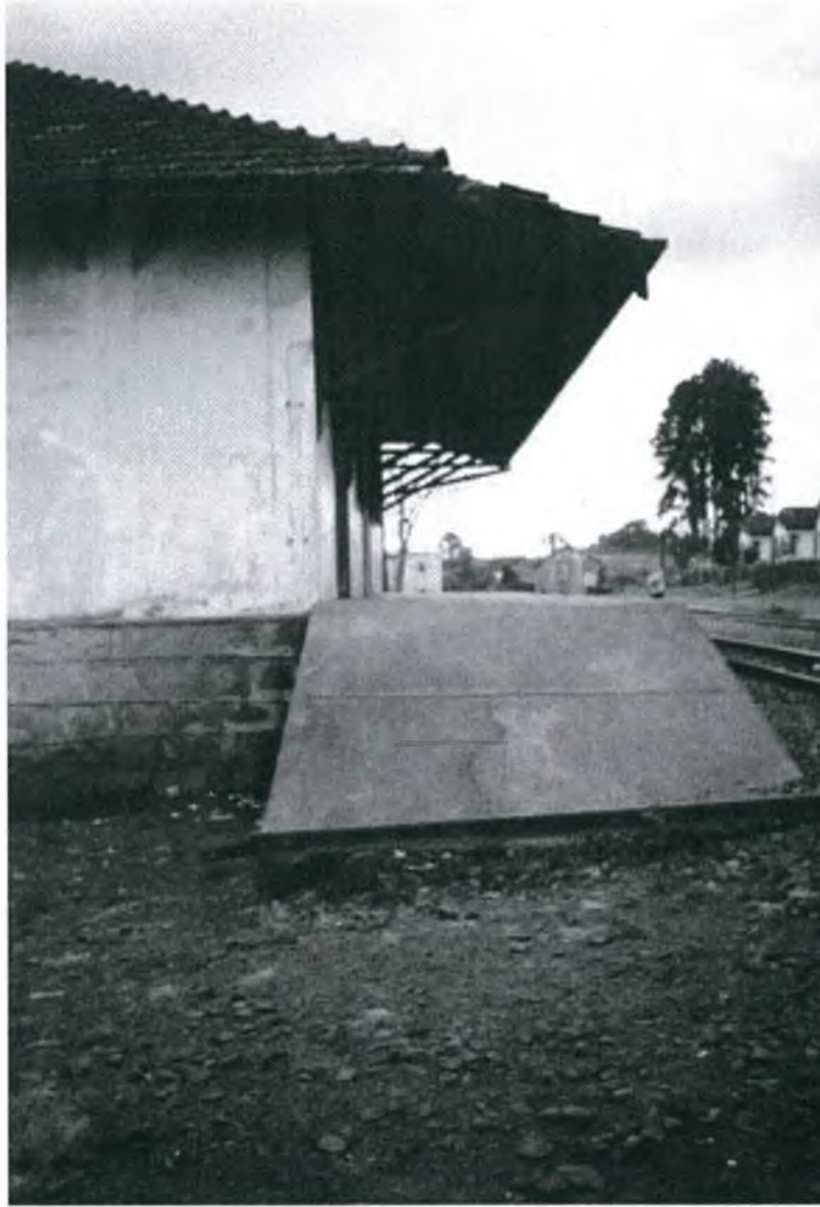
Figura 19 – Fotografia tirada por mim em 22 de julho de 2001. A imagem mostra uma das laterais da estação João Passos . À direita vê-se as casas dos ferroviários, podendo-se verificar com a estação, as casas e os trilhos eram próximos. A estação João Passos está sendo ocupada.
