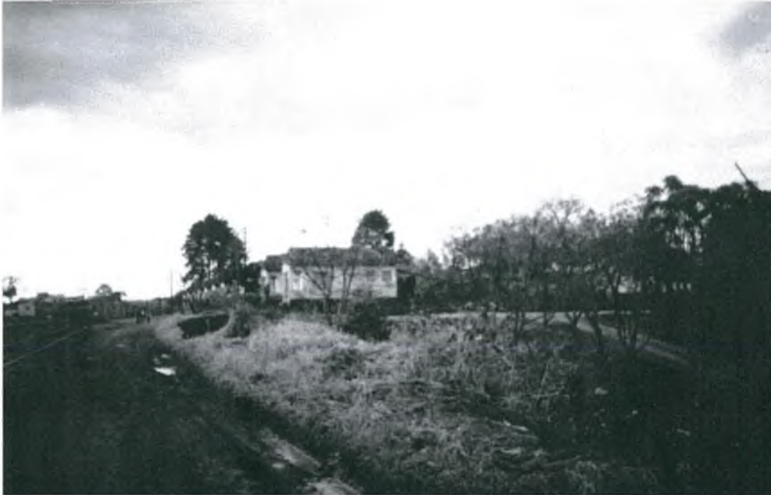
Figura 16 – Fotografia tirada por mim em 22 de julho de 2001. Imagem mostra as casas dos ferroviários que ficam em frente à estação João Passos . Construções de arquitetura idênticas às casas localizadas próximas à estação Afonso Camargo .
