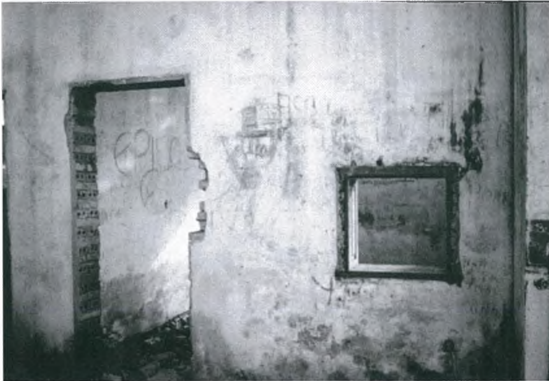
Figura 7 – Fotografia tirada por mim em 22 de julho de 2001. A imagem tem a mesma temática da figura 6 (ou seja, mostra a bilheteria e porta de passagem dos funcionários). Observa-se que só restou o recorte na construção indicando que ali fora porta e janela da bilheteria, não havendo mais nem a porta, nem janela. Além das manchas na pintura, verifica-se que as paredes forma pichadas e riscadas.
