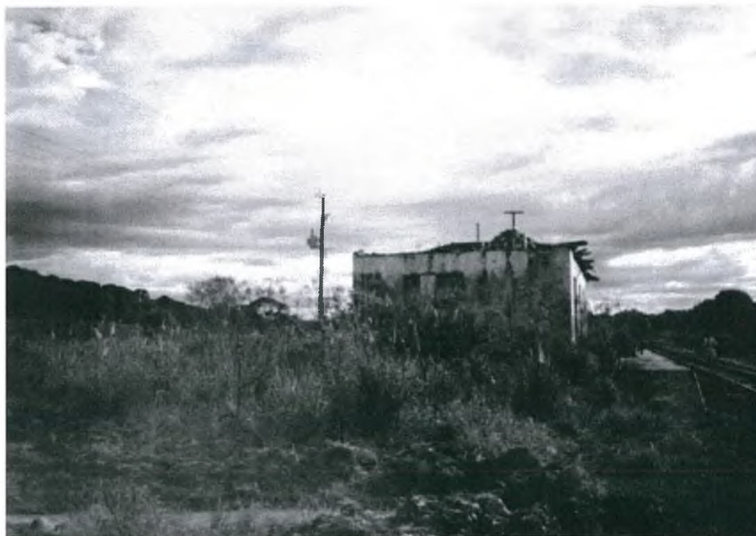
Figura 4 – Fotografia tirada por mim em 22 de julho de 2001. Imagem de uma das laterais da estação. O mato toma conta do terreno, tornando difícil a aproximação.
