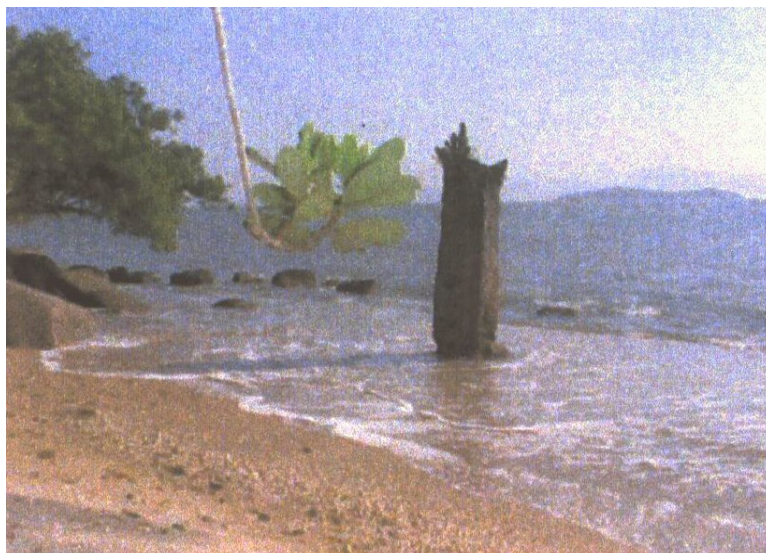
Figura 5 – Pilar remanescente que sustentava a calha de abastecimento de água.
