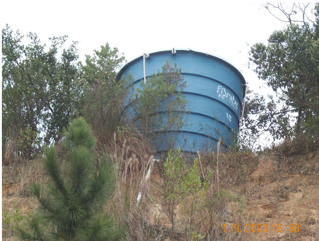
Figura 15 – Exemplo de reservatório encontrado na área piloto – 10.000 litros
