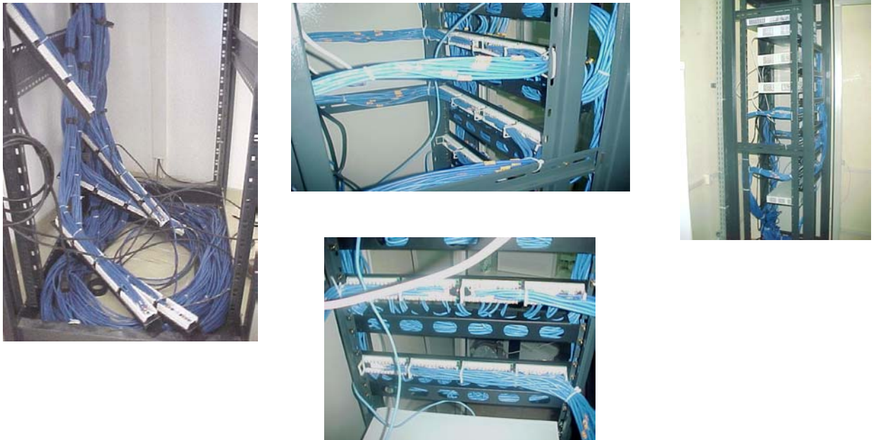
Fig. 59 - Detalhes de montagens de racks
