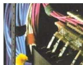
Fig. 58- Instalação de braçadeiras de velcro
