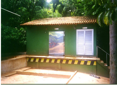
Câmara Fria para Lixo Orgânico e Depósito de Papéis
