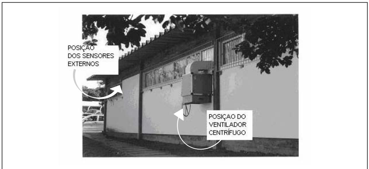
**Figura 28 – Visualização Externa da Localização do Ventilador Centrífugo e do Sensor de Temperatura e Umidade Externo.** Fonte: M<sup>a</sup> Claudia L. Corrêa
