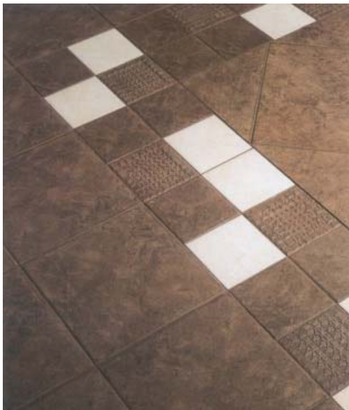
Figura 27 – Modulação de Revestimentos Cerâmicos
