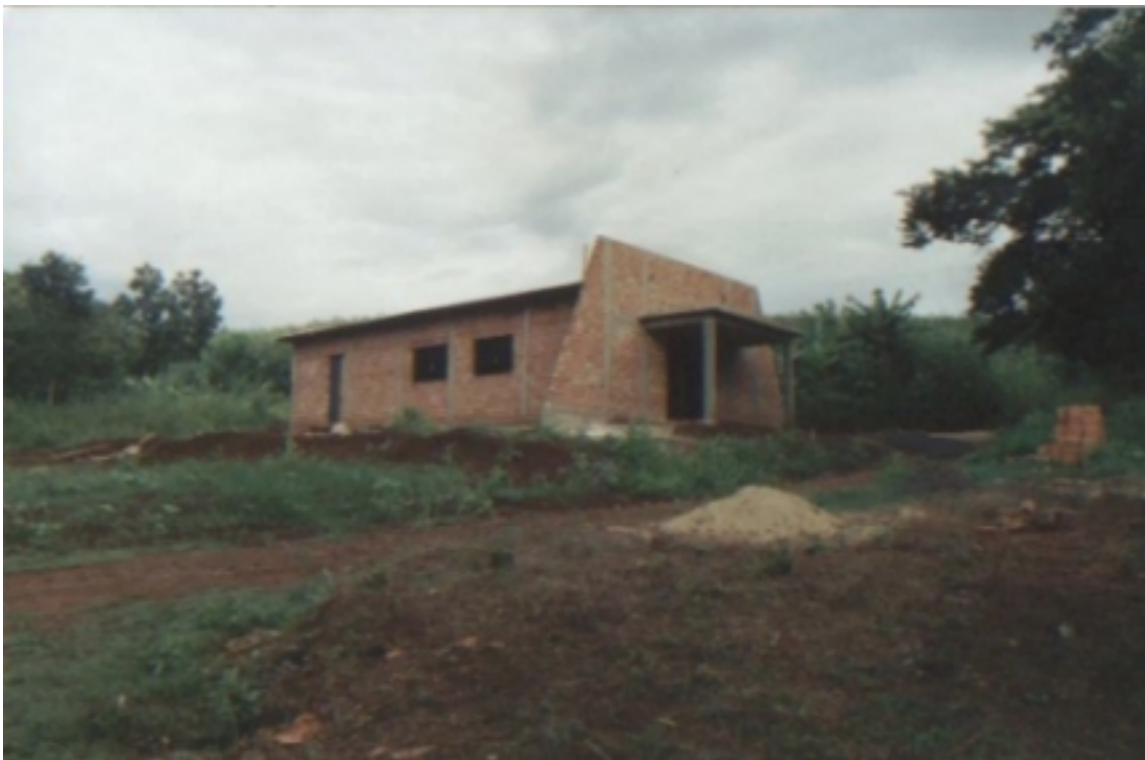
Igreja católica em construção na TI Laranjinha, janeiro de 2002.
