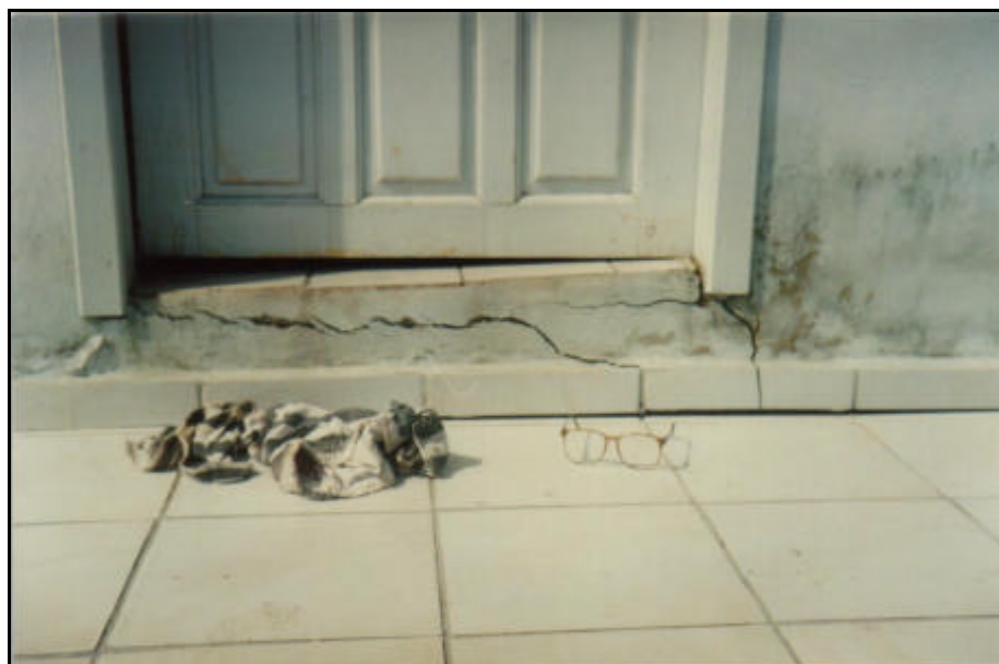
Figura 8 - Dano 8 na viga de baldrame
