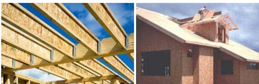
Figura 2 – Utilização do OSB em vigas I e em paredes. (fonte: [www.apawood.org](http://www.apawood.org))
