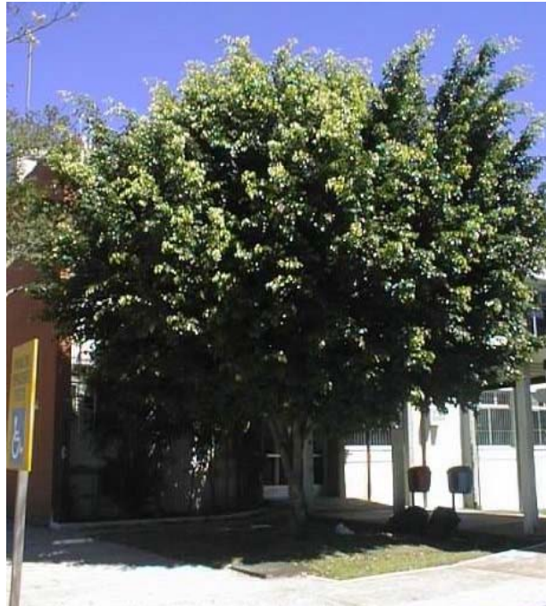
Figura 10: Árvore plantada muito próxima da edificação – Centro Tecnológico
