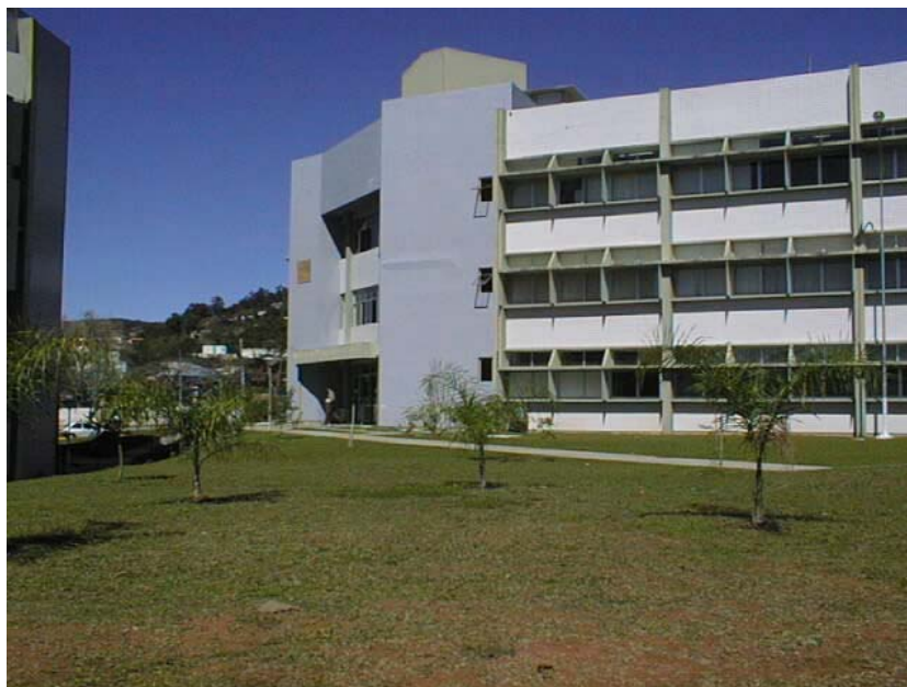
Figura 12: Brises nas janelas para conter os raios solares no prédio da Engenharia Civil
