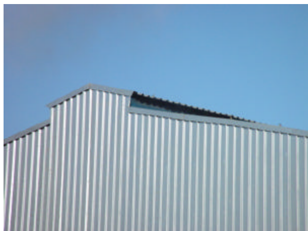
Figura 16 – Detalhe da cobertura do prédio de acabamento
