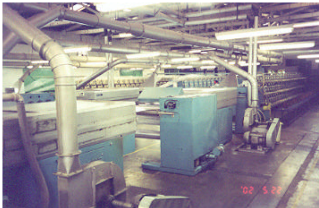
FIGURA 7 – Vista interna do prédio da extrusão
