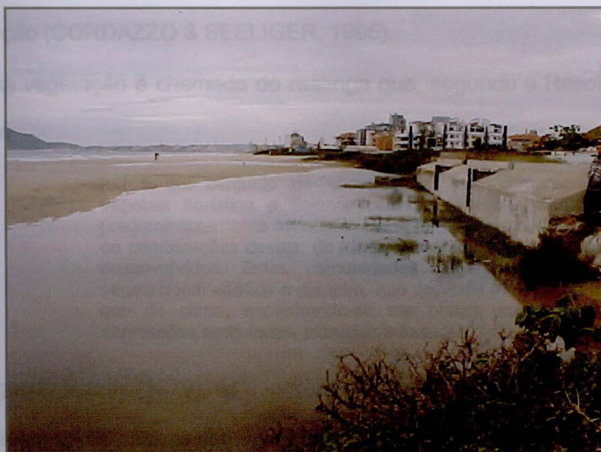
Figura 10 – Acúmulo de água provocado pelo carreamento do sedimento arenoso.
