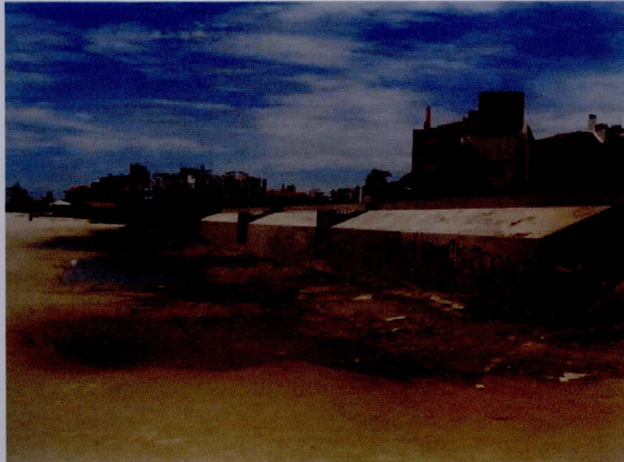
Figura 8 – Muro de contenção.
