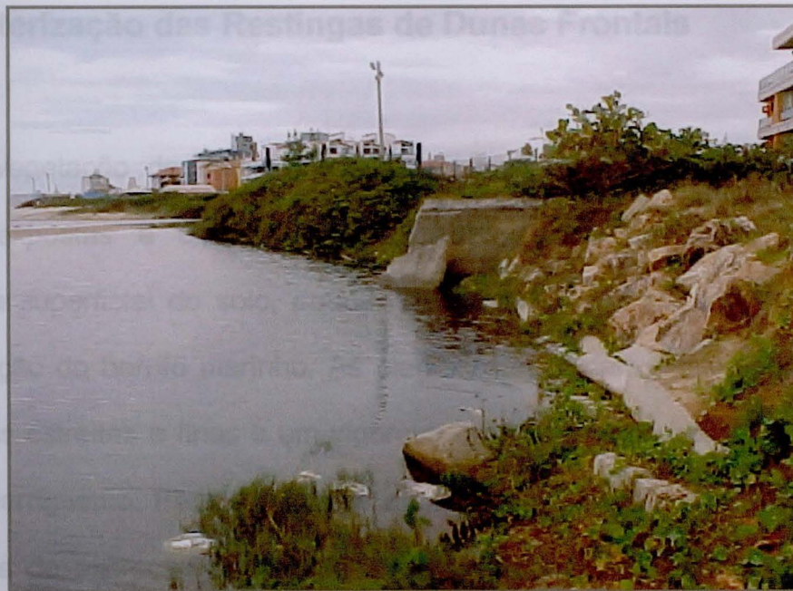
Figura 9 – Aterro feito com entulho (barro, pedra e restos de construção) para conter a erosão marinha.
