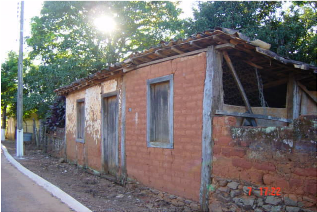
Vista de construção edificada no final do século XIX em péssimo estado de conservação – Santa Cruz de Goiás
