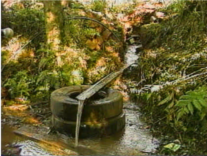
Figura 4.22 – Nascente antes da intervenção. Fonte: SEMA, 2002
