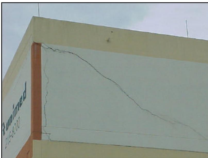
Figura 11 - Fissuras convergindo para o elemento de apoio.
