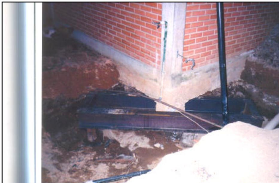
Figura 14 - Caixaão composto de perfis metálicos
