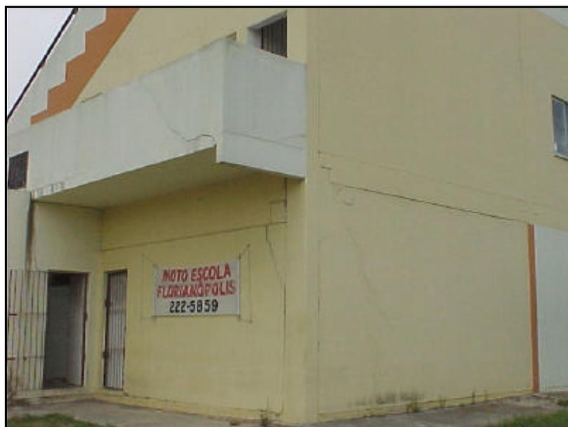
Figura 10 - Fissuras em decorrência de recalque nas Fundações.
