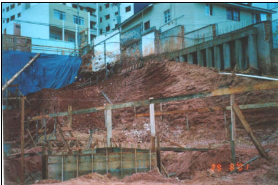
Figura 25 - Perfil do terreno com escavações para o subsolo.
