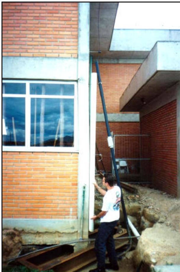
Figura 13 - Pilar com deformações e estrangulamento no encontro com a viga superior.
