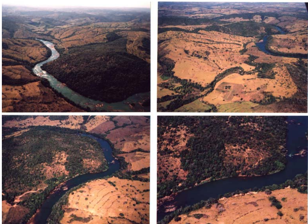
Foto 1: Vista aérea da usina hidroelétrica – Serra do Facão/Rio São Marcos, 2002.
