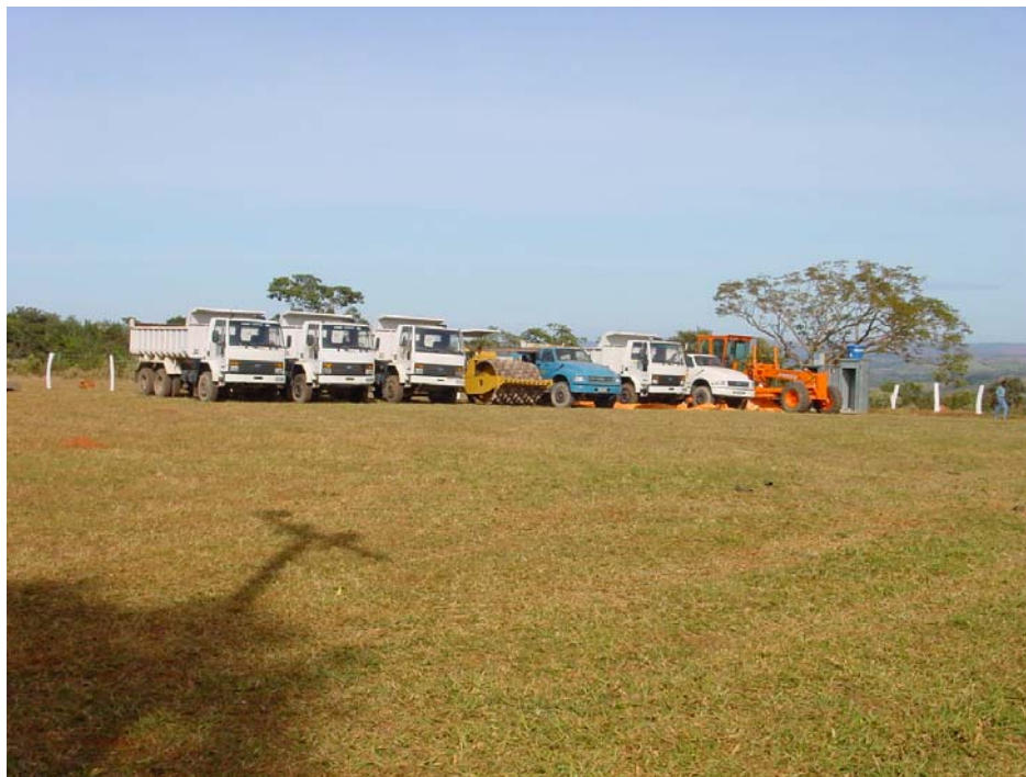
Foto 6: Implantação do canteiro de obra.
