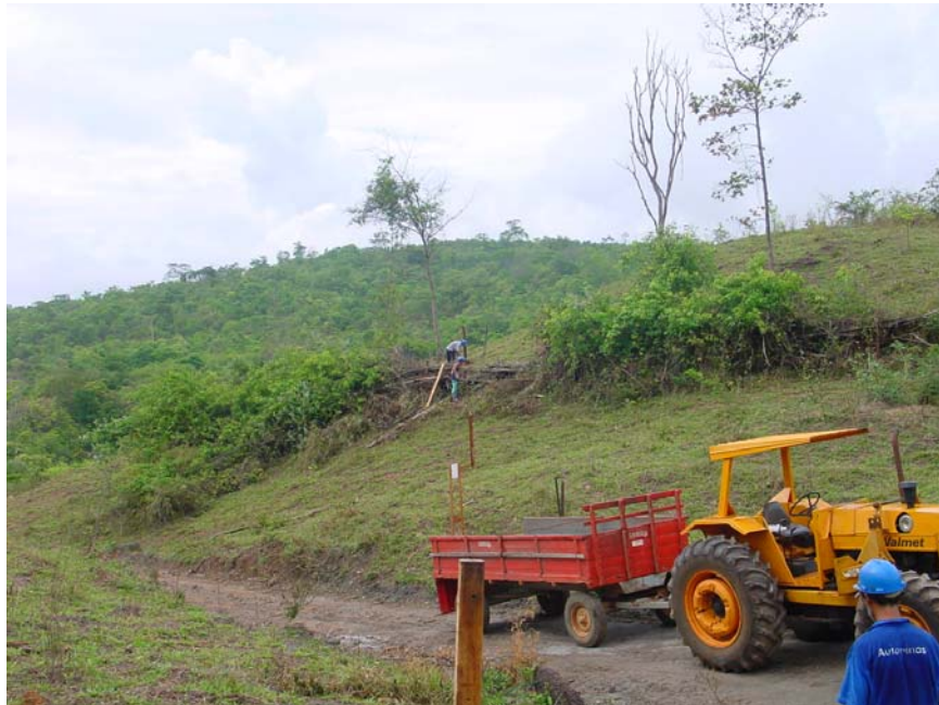
Foto 8: Desmatamento para a construção da cerca da poligonal da obra.
