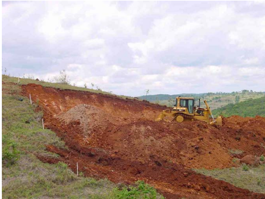
Foto 10: Decapagem da pedreira para detonação.
