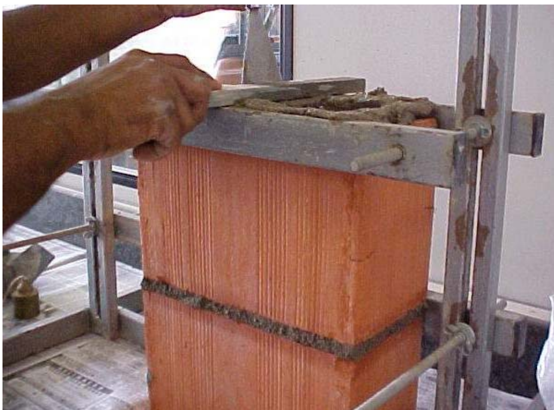
Figura 9 – Execução de prisma utilizando o aparelho de controle de prumo e junta.
