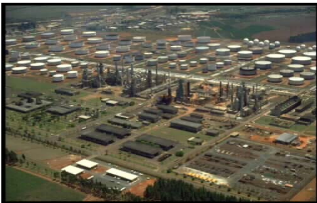
Figura 6.1: Vista Geral da Replan
